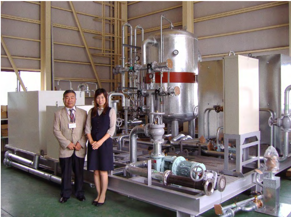
大晃産業にて組み立て中のバラスト水浄化処理プラント（10月5日通水式予定）
